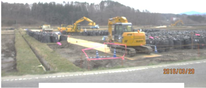
飯館村：ショベルカーとフレコンバッグ
