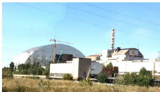
NSC をスライディングして「石棺」を覆う数ヶ月前。 左の大きなアーチ形の建造物が NSC。 (2016 年 8 月に現地で撮影)
