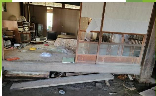
事故後に、イノシシが畑を掘り返し、側溝を埋めてしまったので、床下浸水を繰り返した玄関土間です。土間でした。土でした。
