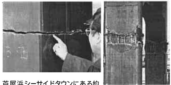
芦屋浜シーサイドタウンにある約40cm四方・肉厚5cmの中空箱形鋼鉄柱416本中53本が破断した
