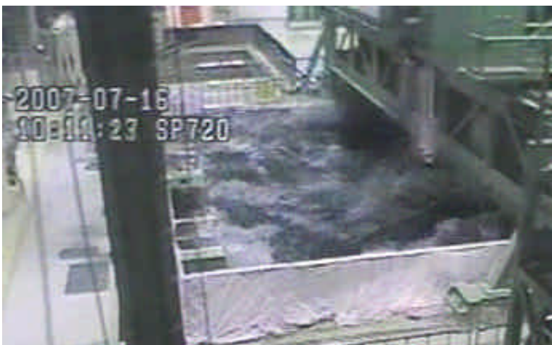
地震動で激しくスロッシングし、泡立つ使用済核燃料貯蔵プール
