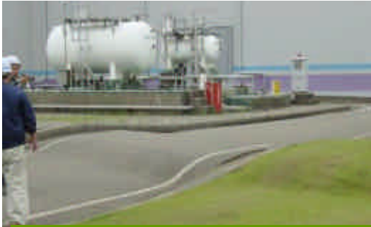
2号と3号(奥)の間の波打つ路面： 2・3号間の配管トンネルの周囲が陥没
