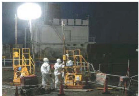
汚染水の海洋流出を防ぐ作業(東電提供)
