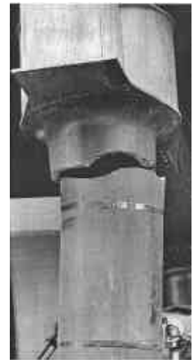
阪神高速鉄道の鋼管柱
