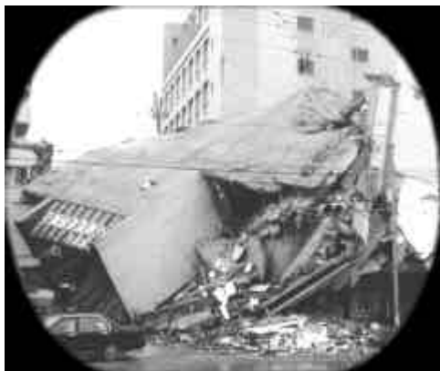
(阪神・淡路大震災で倒壊した建物 1995年1月17日)
