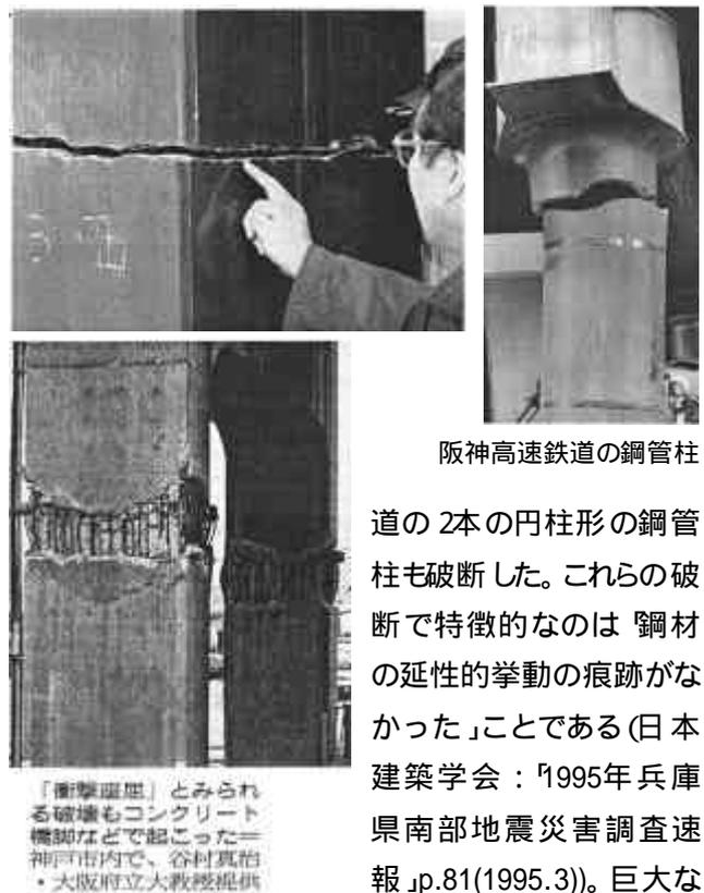
阪神高速鉄道の鋼管柱
