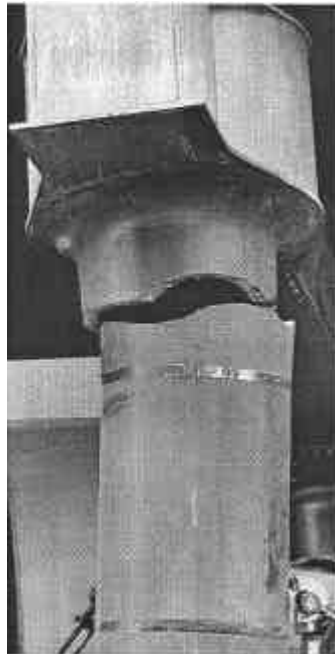
芦屋浜シーサイドタウンにある約40cm四方・肉厚5cmの中空箱形鋼鉄柱416本中53本が破断した
